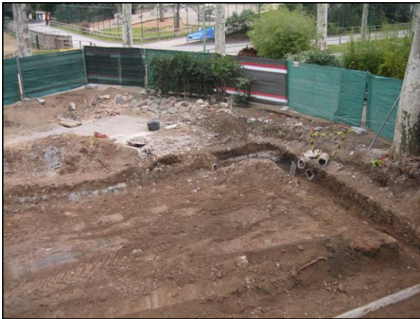
FOTO 5. Vista parcial del solar amb el rebaix a 5,95 m efectuat i les rases per als fonaments efectuades
