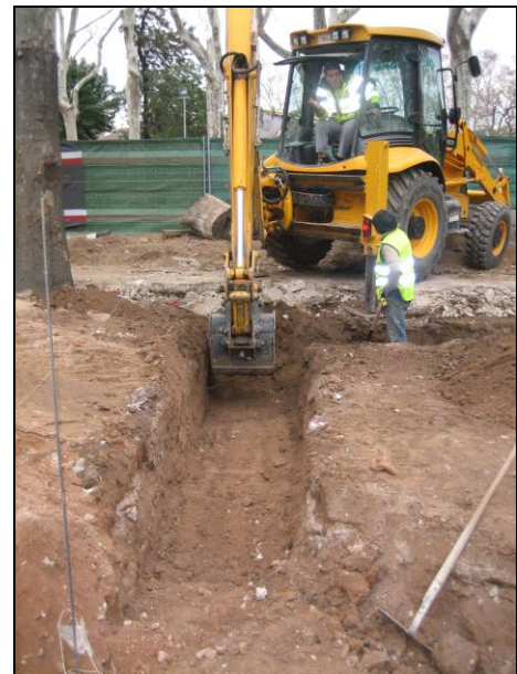
FOTO 4. Excavació dels fonaments fins els 5,5 m snm
