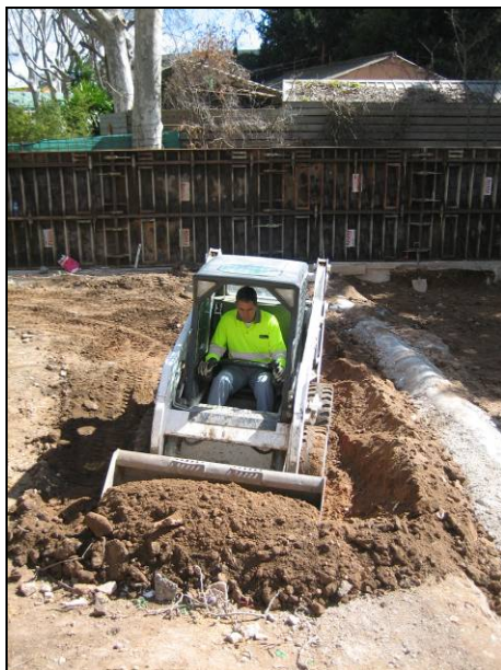
FOTO 7. Rebaix de l'interior del perímetre definit pels nous fonaments fins a la cota 5,5 m snm
