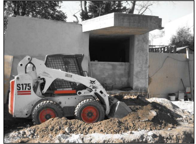
FOTO 6. Rebaix de l'interior del perímetre definit pels nous fonaments fins a la cota 5,5 m snm
