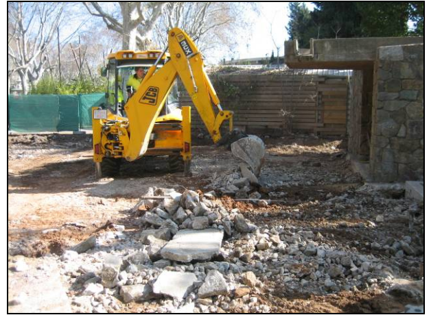
FOTO 2. Retirada del formigó que havia estat picat prèviament
