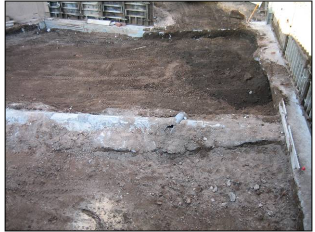
FOTO 10. Vista parcial del solar amb el rebaix a 5,5 m snm finalitzat
