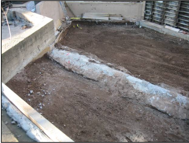
FOTO 9. Vista parcial del solar amb el rebaix a 5,5 m snm finalitzat
